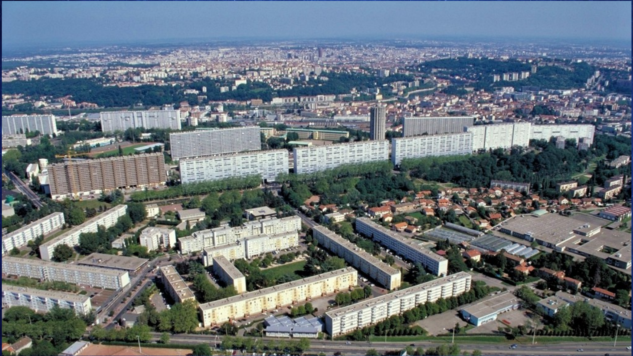
LE QUARTIER DE LA DUCHÈRE AVANT LA DESTRUCTION DES BARRES
