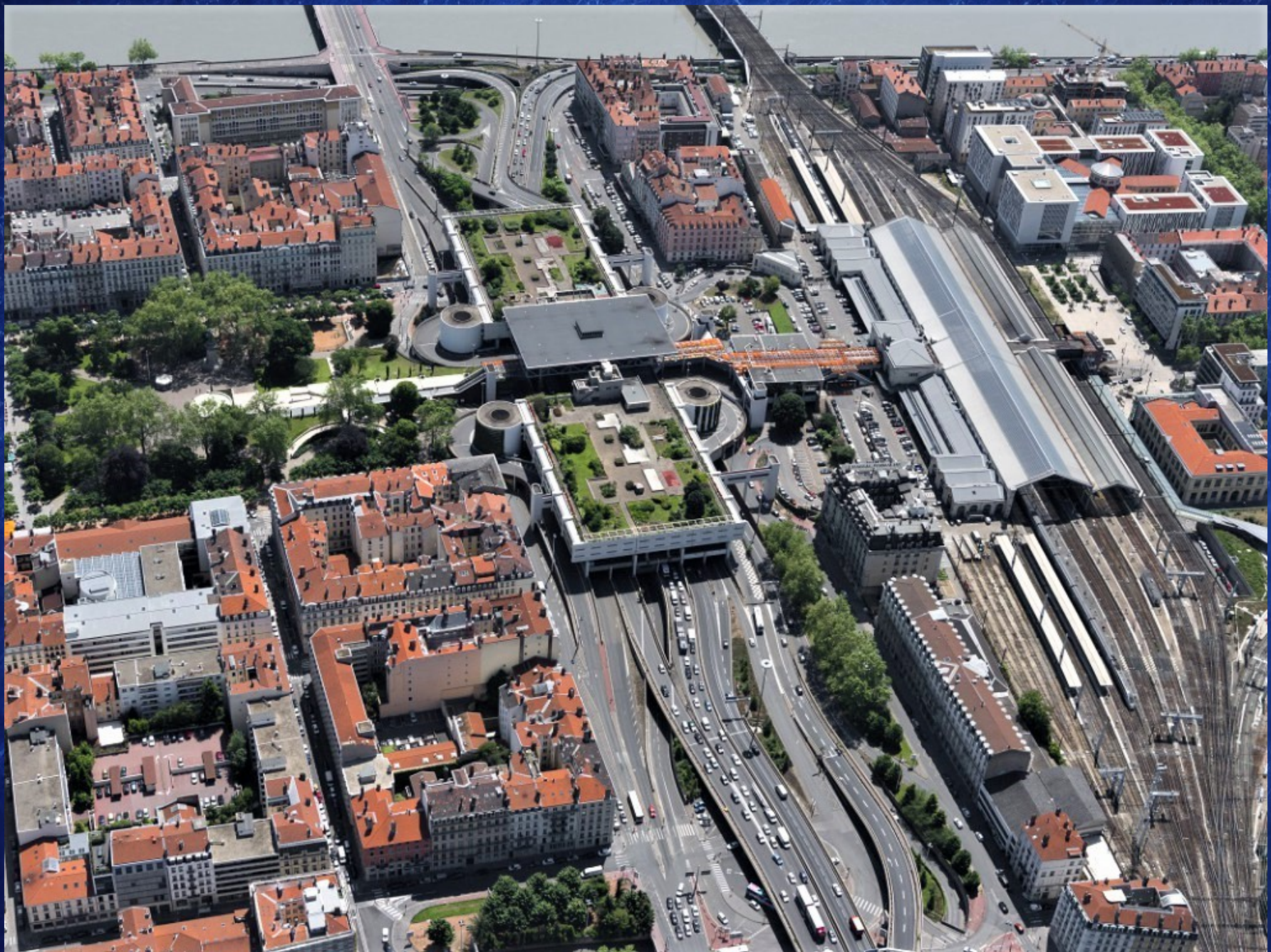
LA PLATEFORME MULTIMODALE DE LYON-PERRACHE Elle associe une gare TGV, deux lignes de tramways, des voies rapides et un réseau complet de bus
