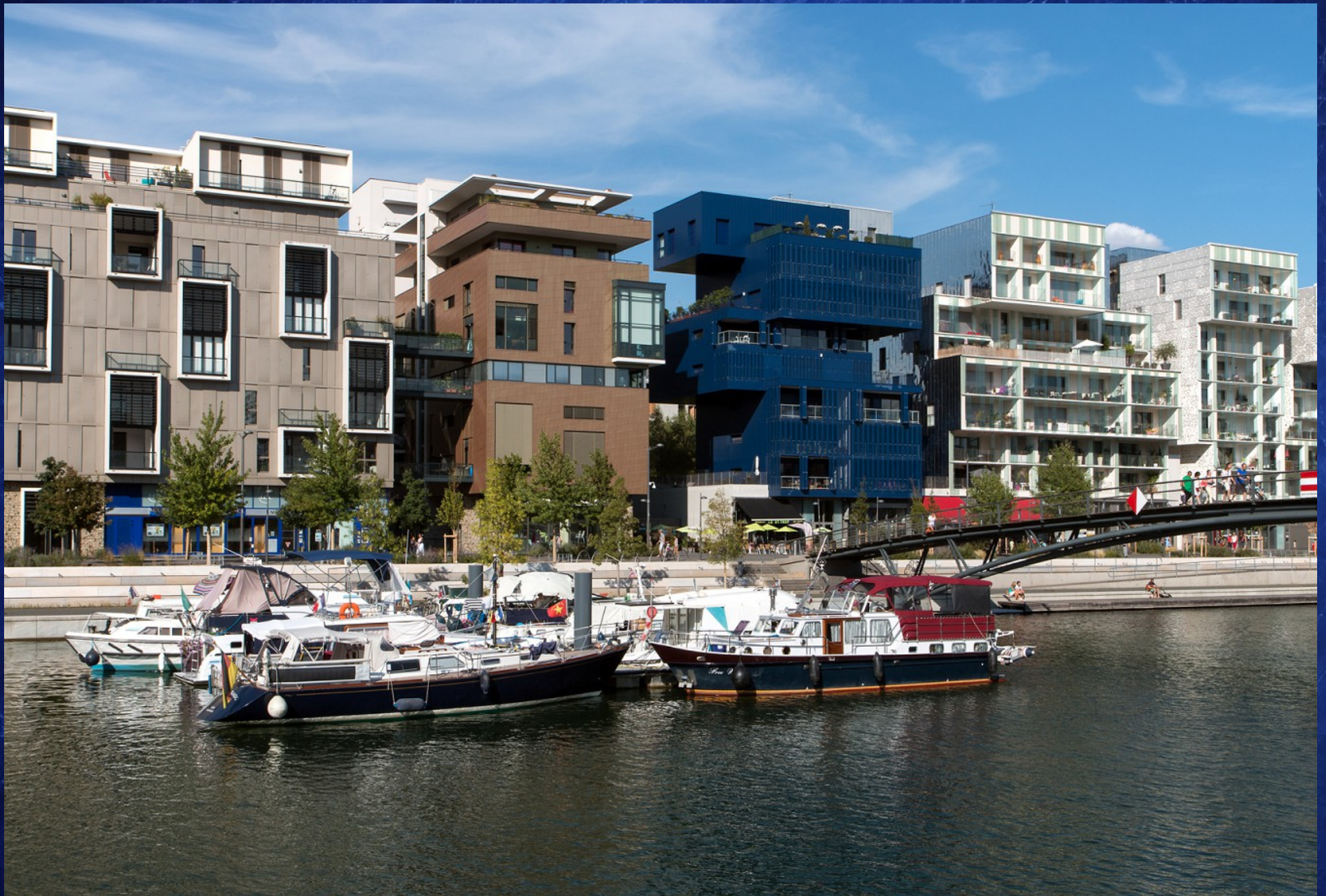
RÉSIDENCES DE L'ÉCOQUARTIER CONFLUENCE À LYON
