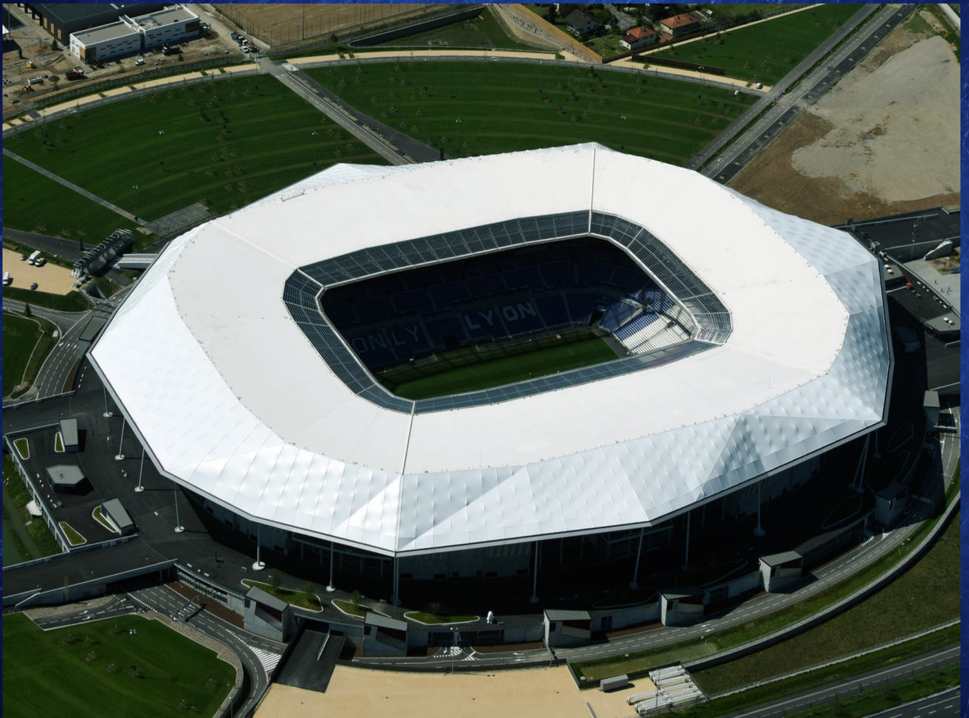
LE PARC OLYMPIQUE LYONNAIS (GROUPAMA STADIUM)
